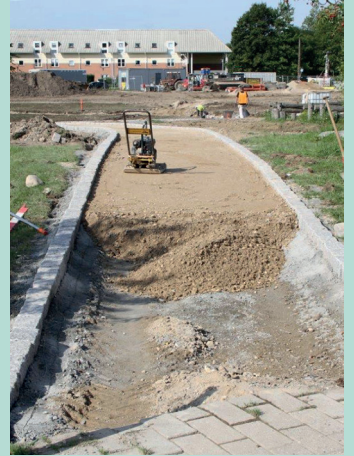
Ny sti under anlæg
