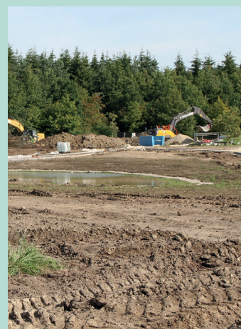
Området under byggermodning
