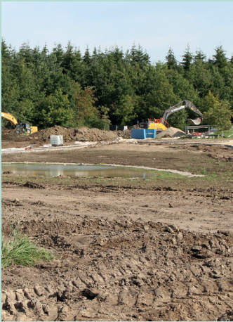
Ny sø under anlæg
